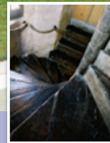
L'escalier classé Listed stairs
