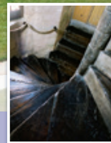
L'escalier classé Listed stairs
